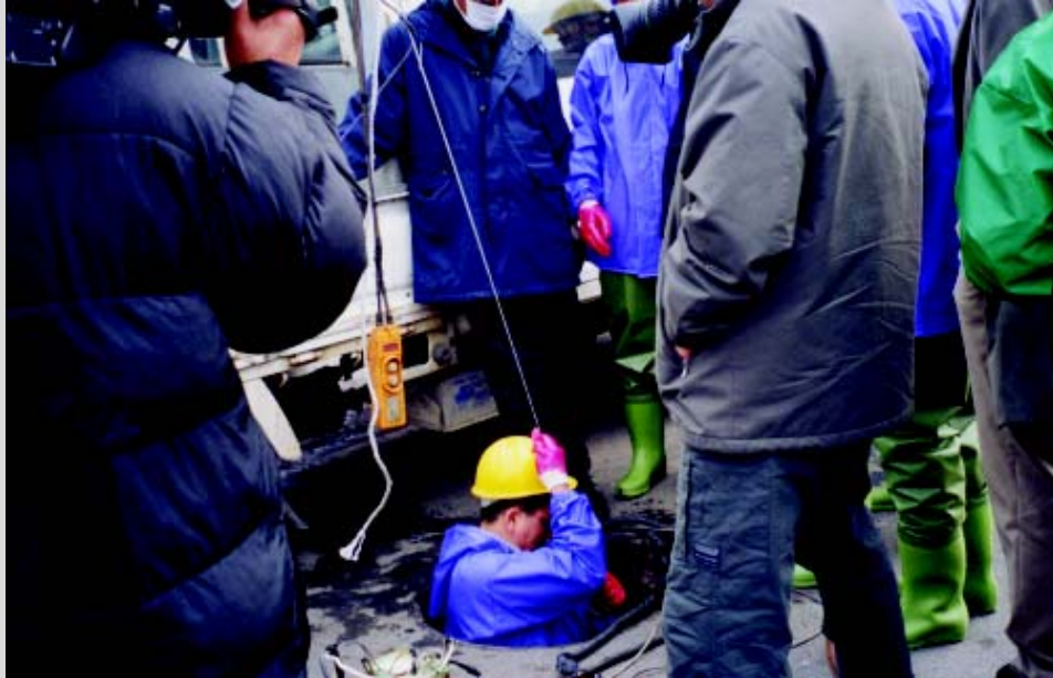
◀ 성남약국앞 역사이편 설치장소 확인을 위해 대하수도에 들어가는 장면 (2002. 11. 20)
