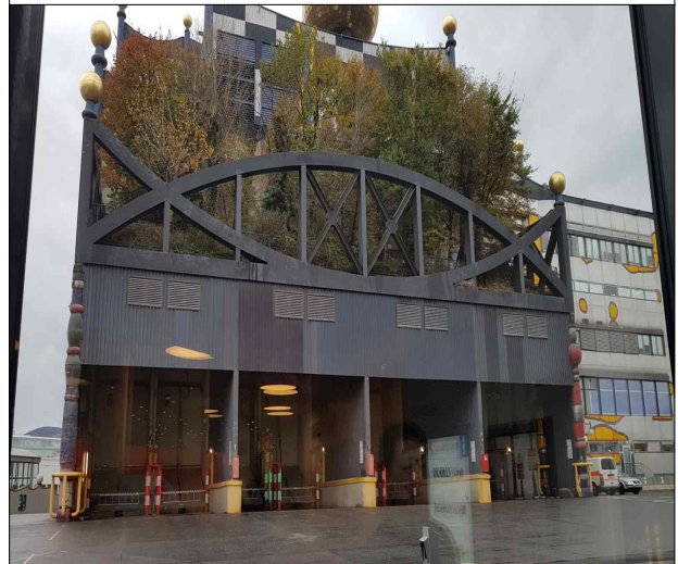
쓰레기 소각장 건물 (나무가 심어짐)
